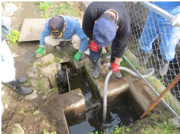
サイホン水路の水をポンプで吸上げ
