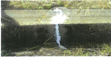
水路の漏水防止目地補修
