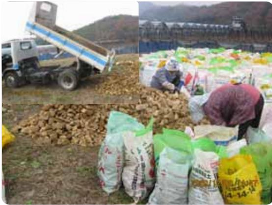
搬入された資材を、袋詰め後トッパで搬送し、人力での埋設をするため、適材適所の分担作業。
