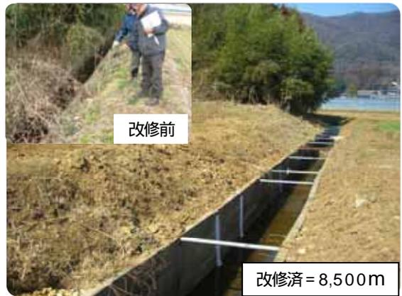
4年に及ぶ改修作業の結果、全水路の改修が完了し残すは不具合箇所の見直しのみとなった。
