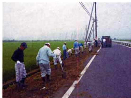
土を被せ穴埋めする
