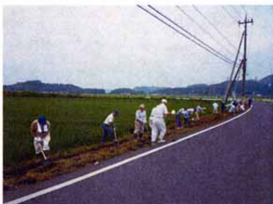
町道路肩の穴掘り
