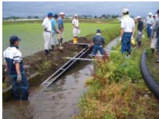
[No.3] 可動式、角型 U 字溝 L=4m
