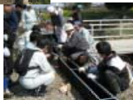
受台 魚道 組み立て
