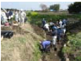
設置箇所の整備
